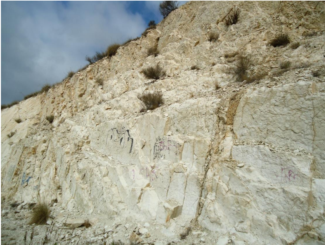
Figura 2. Talud excavado en un macizo rocoso en la ciudad de Alicante, España
