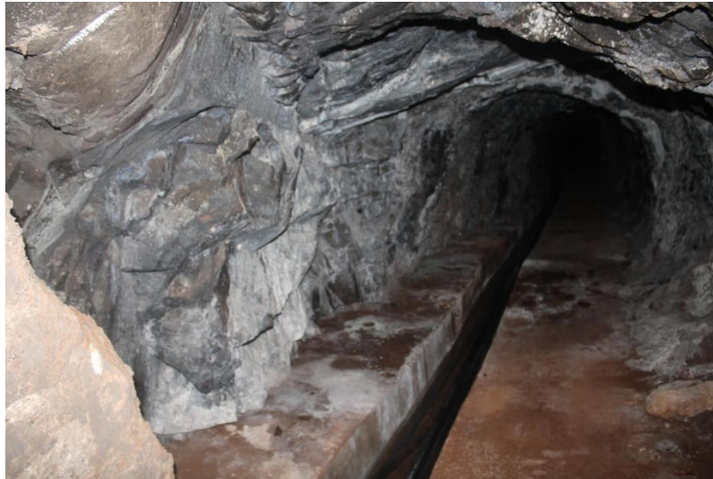
Figura 4. Interior de una galería de agua en Canarias. Fuente: Santamarta, J.C.
