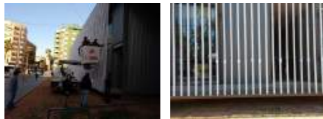
Fotografías del resultado final, una vez acabadas las operaciones de colocación en fachada de las piezas.
