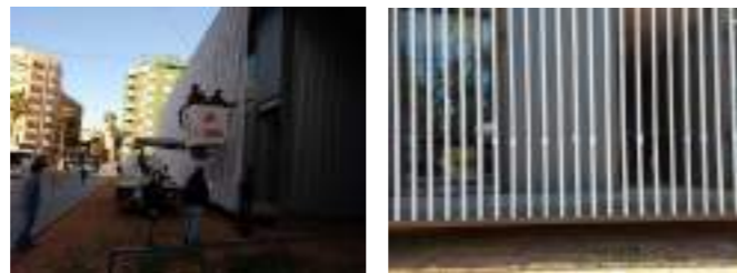
Fotografías del seguimiento del montaje en la propia fachada de la BUC, dirigido in situ por los alumnos Carles Soler Plà, David Gimeno Alonso y Ariel Corzantes Barillas. Marcas de papel con la indicación de la altura precisa de colocación de las flores en cada barrote, colocadas por los alumnos que controlaron las operaciones de montaje.
