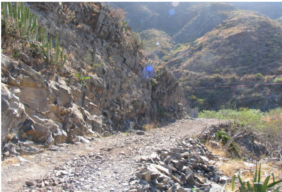
Figura 16.3 ; Excavación en roca de basalto mediante explosivo (Santamarta JC, 2011)
