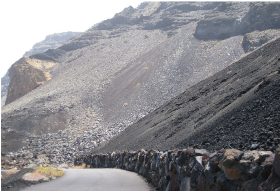
Figura 16.9 ;Obra de protección de ladera con piroclastos volcánicos, en la isla de El Hierro. (Santamarta JC,2009)
