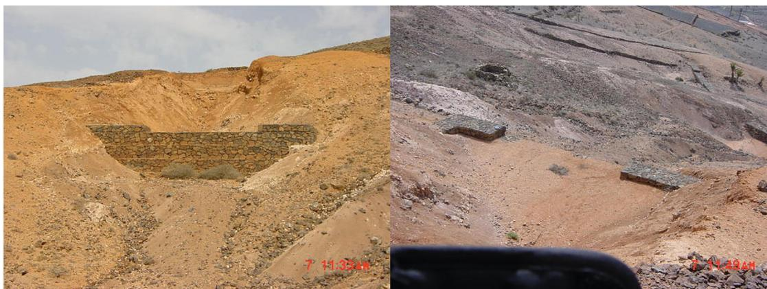
**Figura 14.11:** Dique en Barranco de Tenesía, Lanzarote. Construido en 1996 y ya colmatado en 2001. Fte: Catálogo Regional de Hidrotecnias (Gobierno de Canarias 2002)
