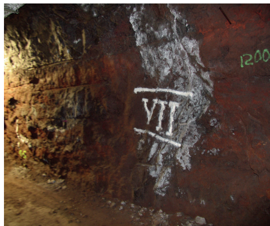
Figura 3.9.- Dique geológico dentro de galería y nomenclatura de números romanos utilizada por el Ingeniero Carlos Soler (2004) en sus perforaciones.
