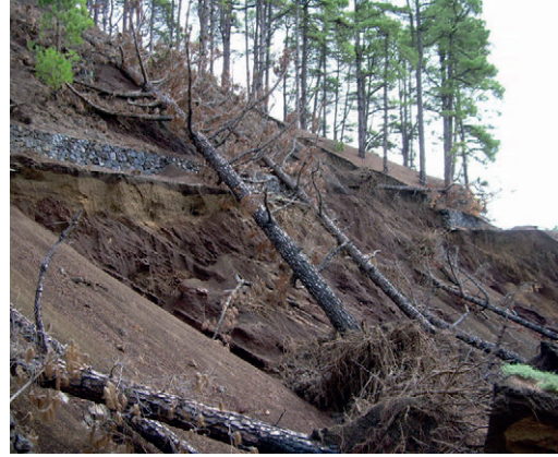
Figura 2.4.- Deslizamiento debido a lluvias torrenciales en la isla de El Hierro.
