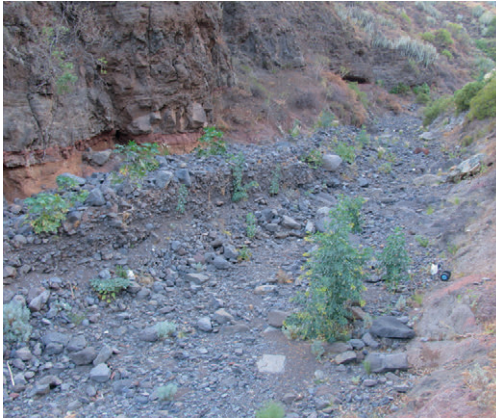
Figura 2.8.- Arrastre de sólidos en un curso de agua de un barranco.
