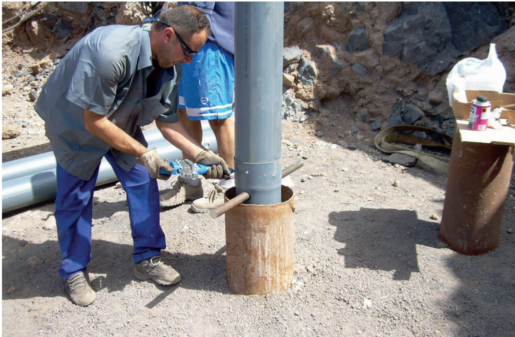
Figura 4.6.- Entubado de un sondeo.
