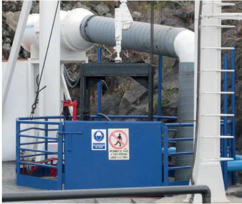
Figura 4.3.- Acceso a un pozo-galería.
