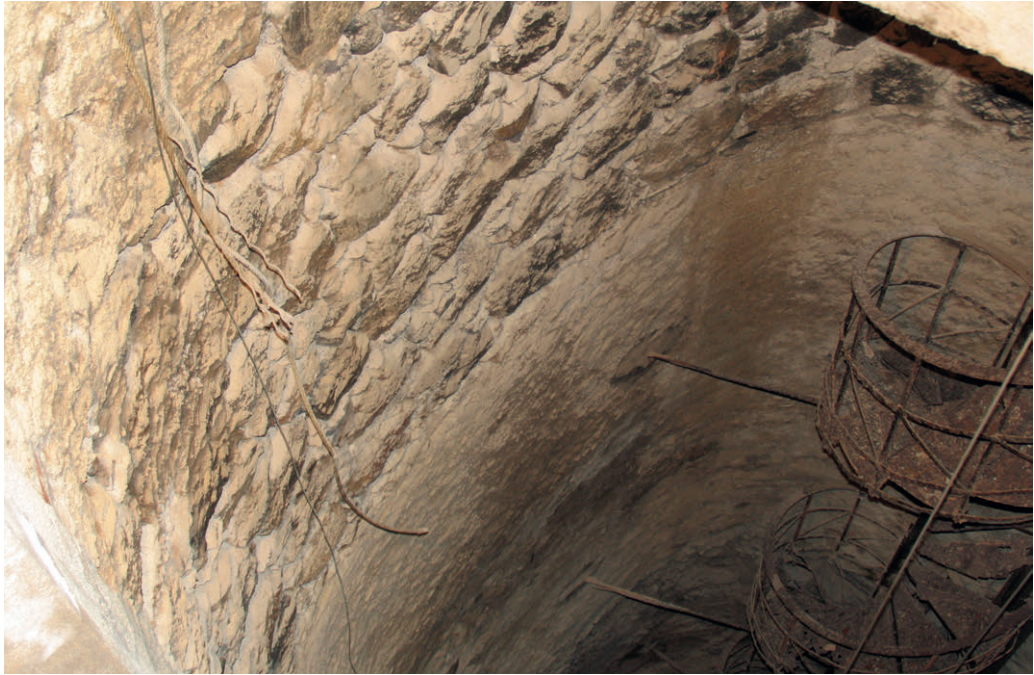
Figura 4.5.- Caña del pozo revestida.
