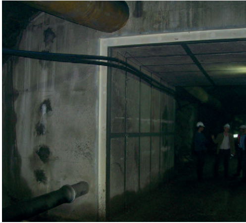
Figura 5.17.- Cierre de hormigón en la galería de Iplán, en la Gomera.
