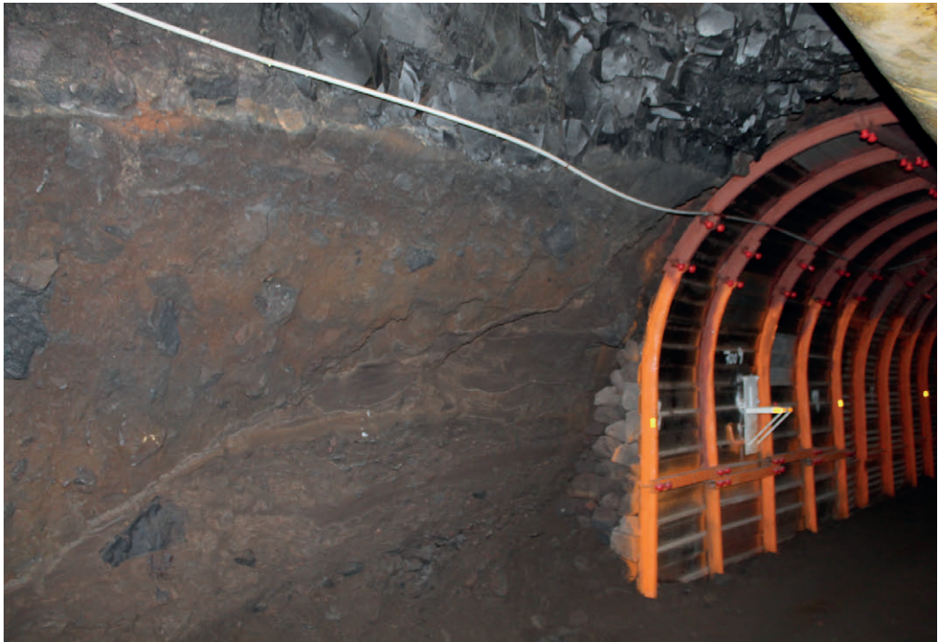
Figura 5.13.- Depósitos coluviales en la traza de la galería.
