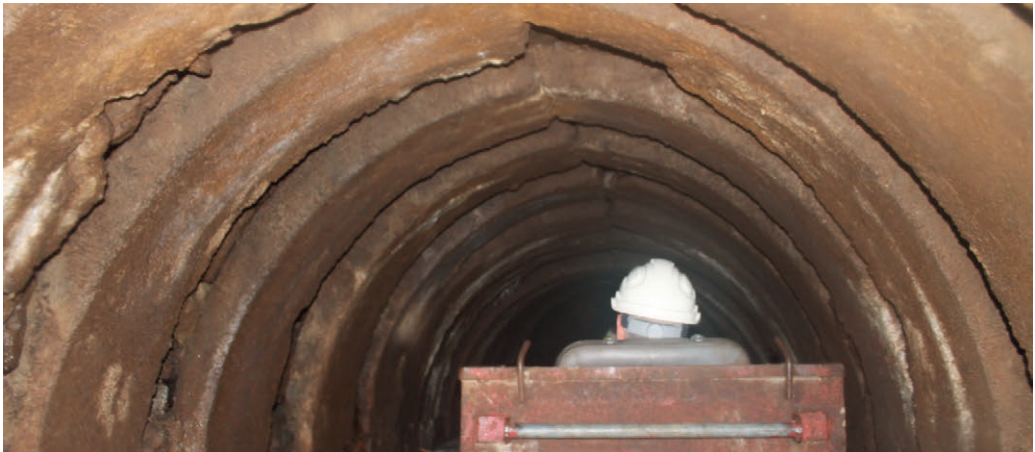
Figura 5.10.- Refuerzo de la sección de la galería mediante bloques.
