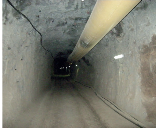
Figura 5.2.- Tramo de galería en construcción por parte de la Administración.
