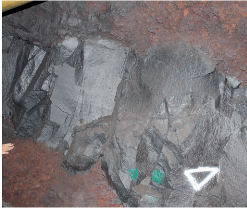
Figura 5.3.- Dique geológico en la traza de la galería.
