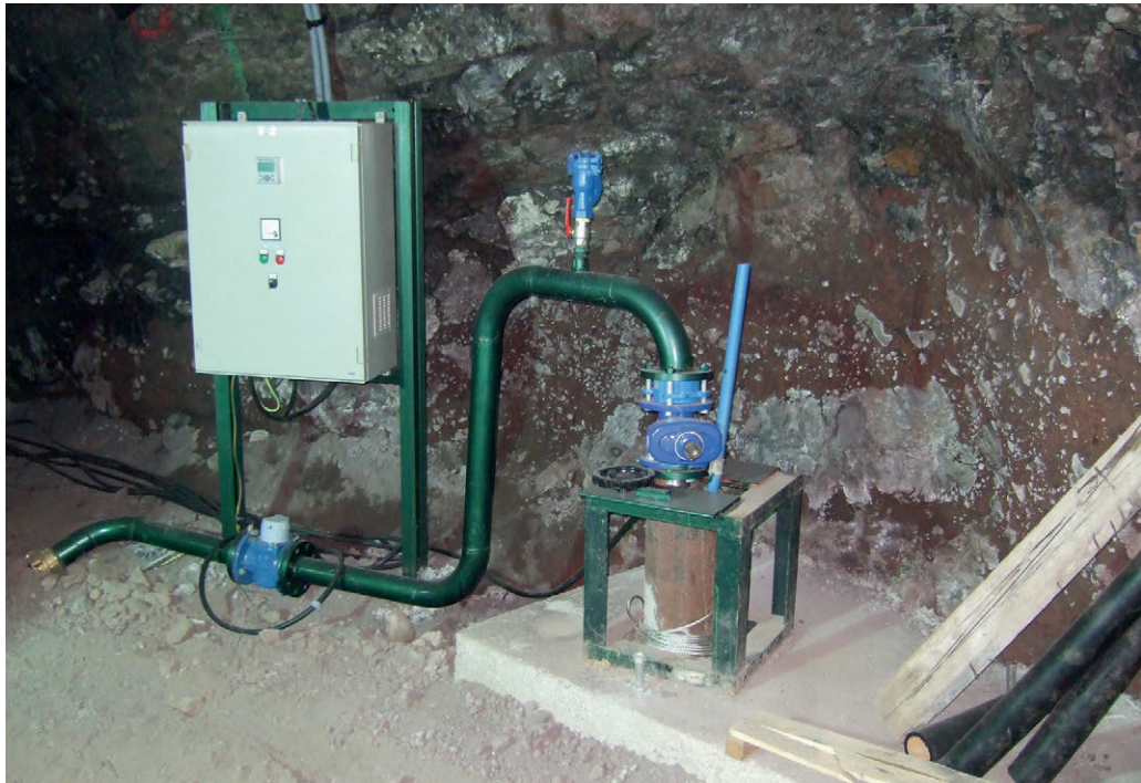
Figura 5.15.- Sondeos verticales en la traza de la galería de Ipalán en La Gomera.
