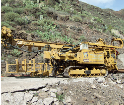
Figura 5.6.- Máquina para la ejecución de sondeos.
