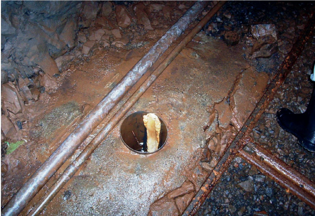
Figura 5.16.- Piezómetro en la traza de la galería.
