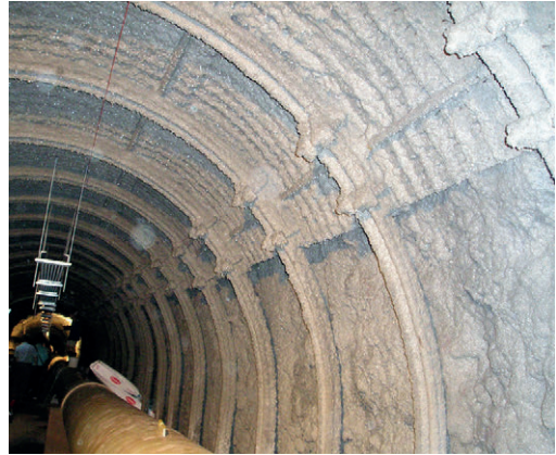
Figura 5.9.- Gunitado en la sección de la mina.
