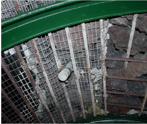
Figura 5.8.- Inyectado en la traza de la galería.
