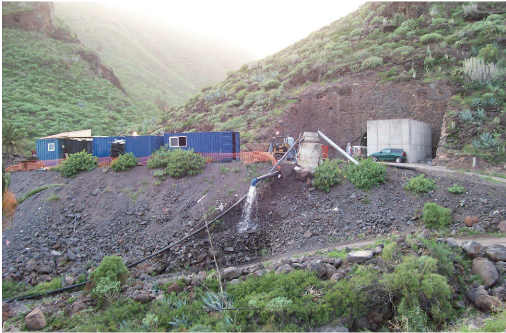
Figura 5.5.- Evacuación de caudales durante la ejecución de la galería.
