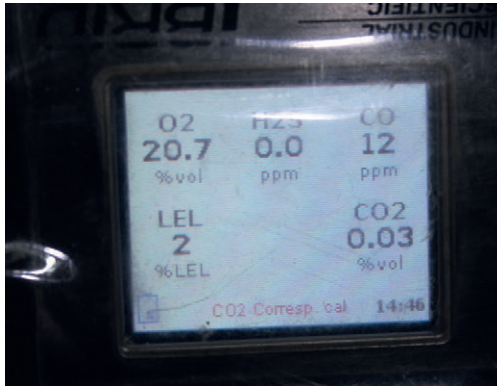
Figura 7.5.- Detector personal de gases dentro de la galería.
