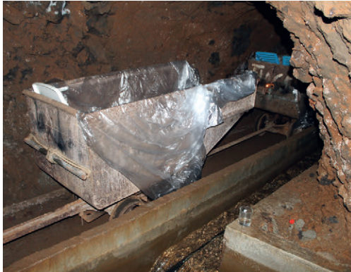
Figura 7.3.- Convoy de vagonetas y espacio disponible de paso en la sección de la galería.
