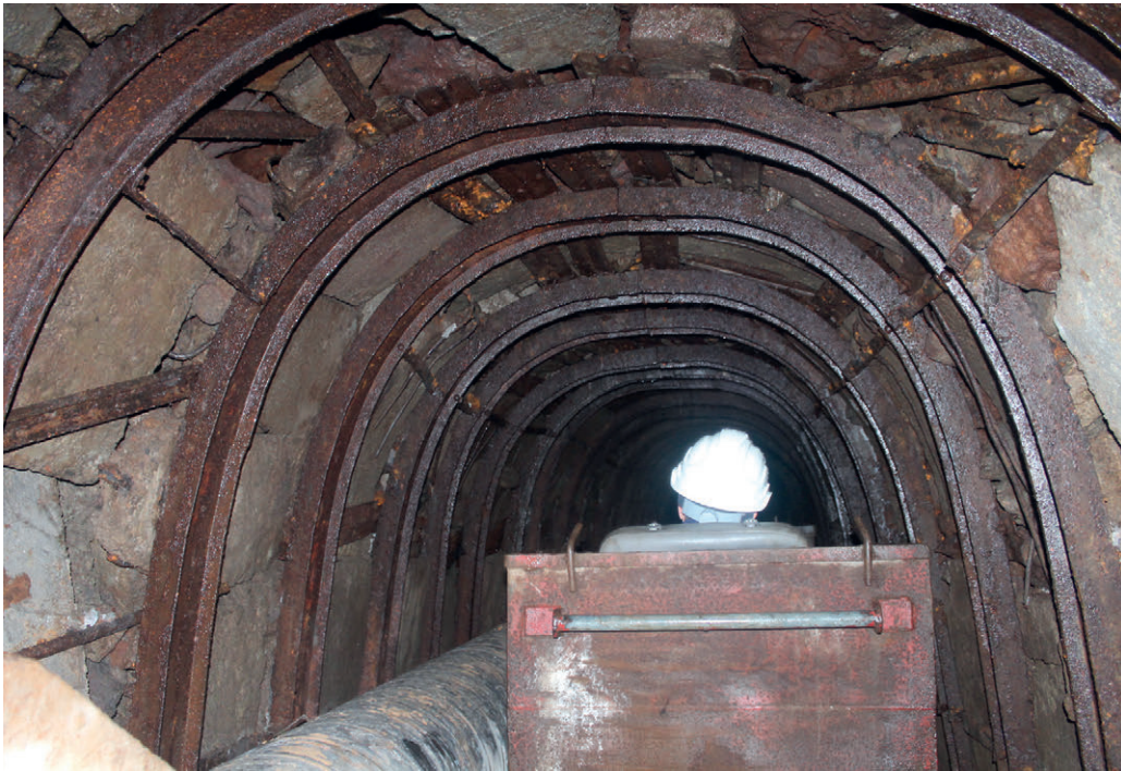
Figura 7.2.- Archetado de la sección de una galería.
