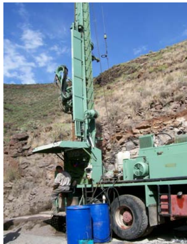
Figura 4 Ejecución de un sondeo en la Isla de la Gomera (Santamarta, 2008).
