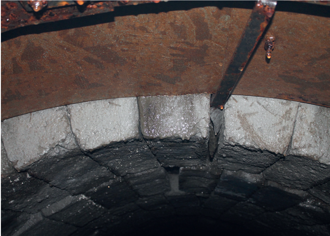
Figura A.13.- Revestimiento con bloques de hormigón macizo.
