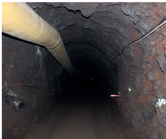
Figura A.14.- Ventilación flexible para adecuar la atmósfera de la mina en el proceso constructivo de la misma.
