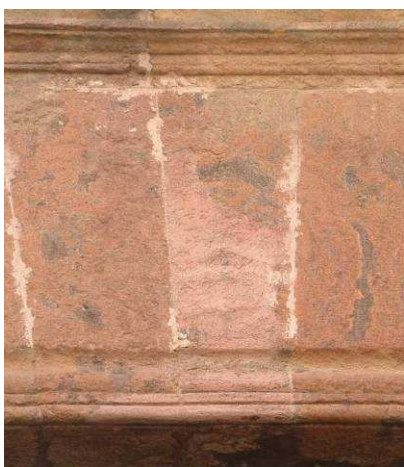
Dintel Portada Casa del Corregidor y detalle de abujardado (Los elementos que aparecen en color claro son morteros).
