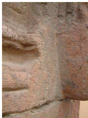
Dintel Portada Casa del Corregidor y detalle de abujardado (Los elementos que aparecen en color claro son morteros).
